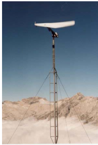
Fig.11 Aerogenerador de una pala
