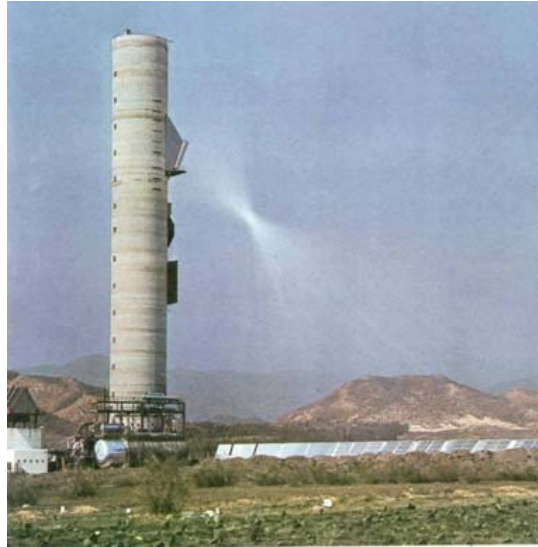
Fig40 Torre central de la CESA-1 y plano parcial del campo de heliostatos
