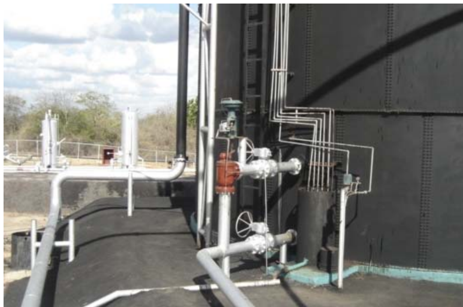
Figura. 5.15. Toma de muestras de crudo en el tanque de lavado.
