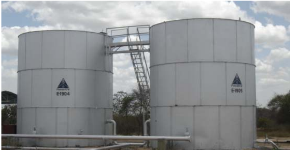
Figura. 5.6. Tanques para almacenamiento de agua salada de EEF-11.
