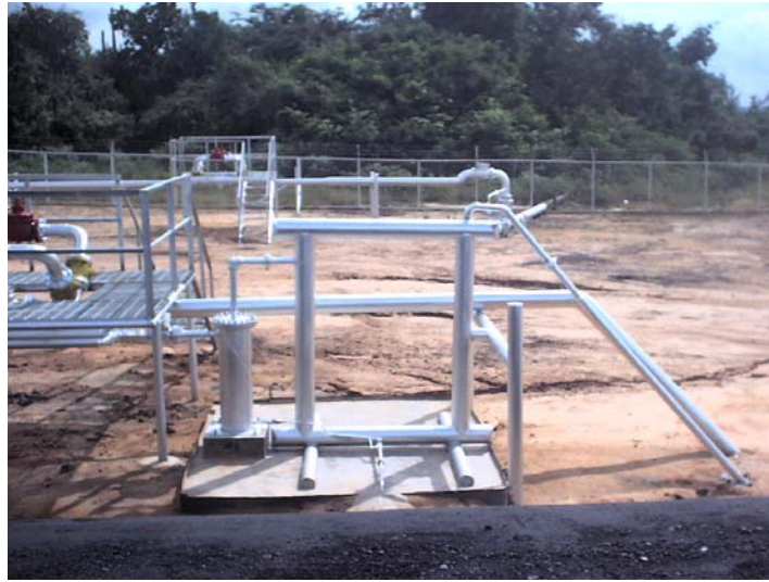
Figura. 5.11. Depurador de gas.
