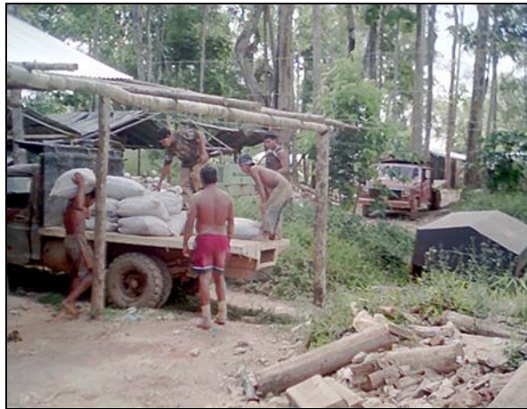
Figura 4.15 Fotografía de la carga de camiones usados como transporte en Hoja de Lata. Fuente: Propia.
