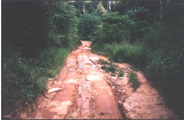
Figura 5.3 Fotografía que muestra el lugar de corte entre la quebrada y la carretera. Fuente: Propia.
