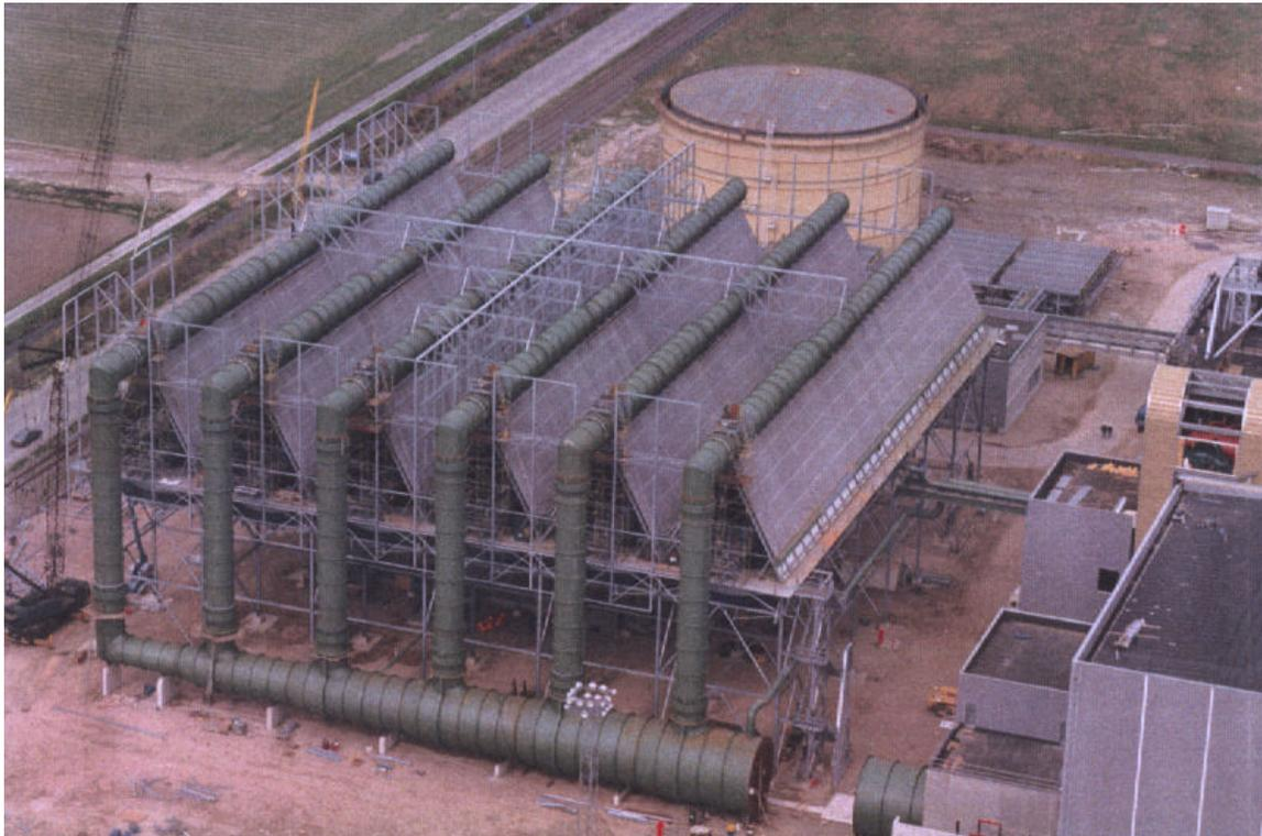
**Figura 3.7: Condensador enfriado por aire tipo A en construcción**
