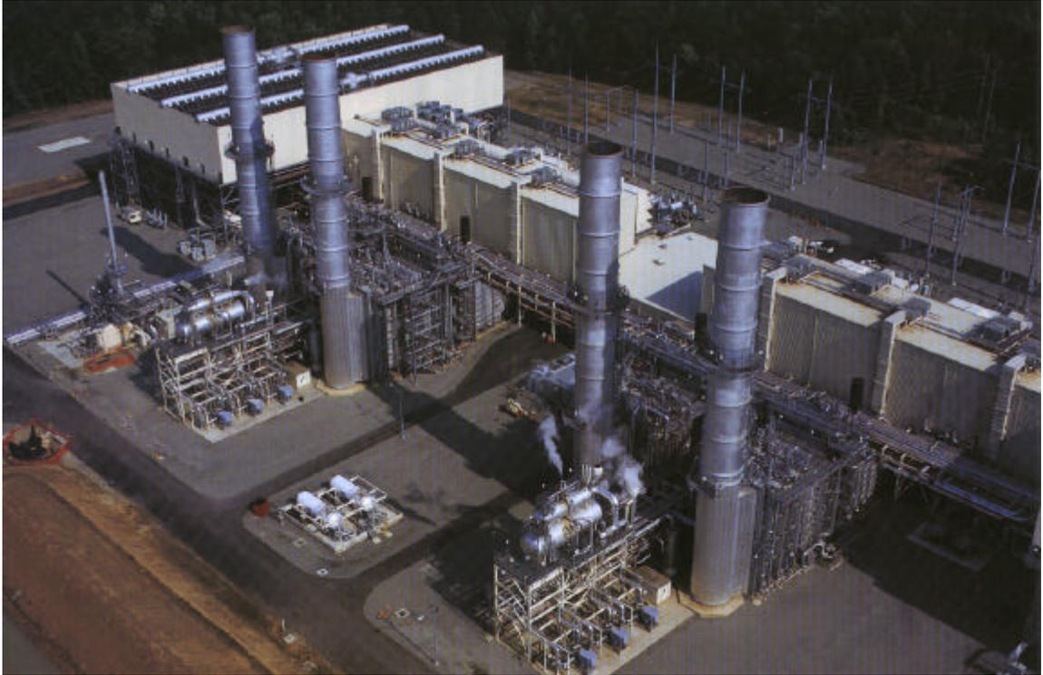
**Figura 1.8: Planta de dos módulos 2x1 de ciclo combinado de 663MW en total localizada en Doswell, Virginia, EE.UU. GVCR de tres niveles de presión, horizontal de circulación natural con combustión suplementaria. Sistema de enfriamiento seco directo**
