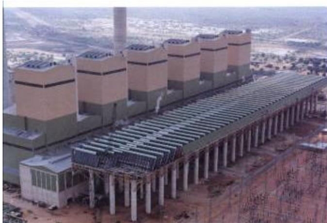
**Figura 3.1: Planta termoeléctrica de carbón de 4.000MW en total (6 unidades ) localizada en Matimba, África del Sur. Sistema de enfriamiento seco directo**
