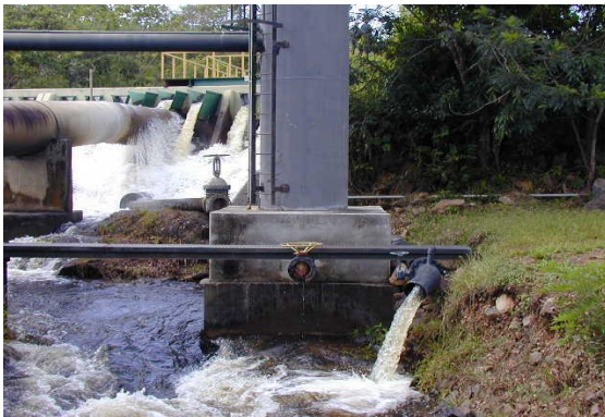
Toma de Agua del Embalse
