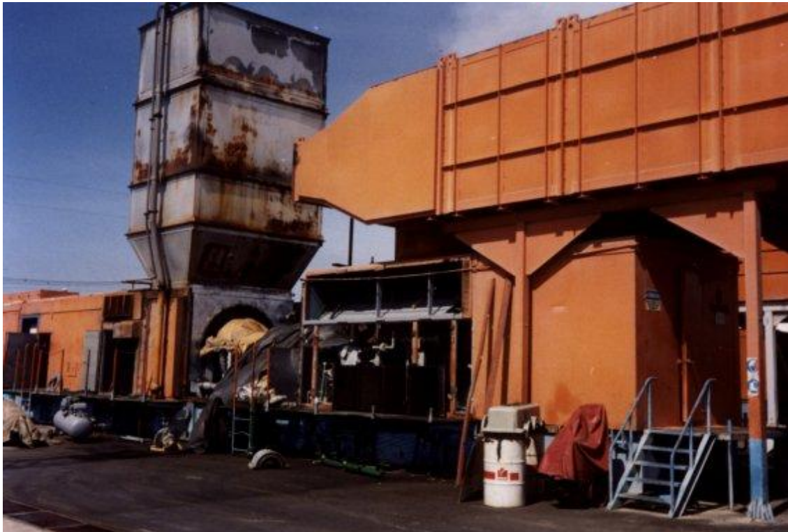
Fig. 5.1 Unidad N° 7 en labores de mantenimiento mayor
