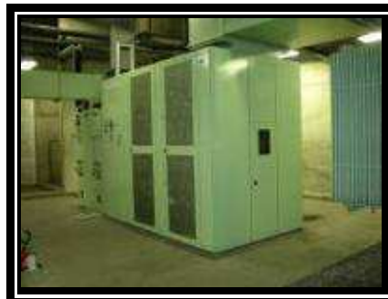
Fig. 1. 9.- Rectificador de potencia (630 Vca → 750 Vcc) Líneas 1 y2 perteneciente a Metro de Caracas C.A.
