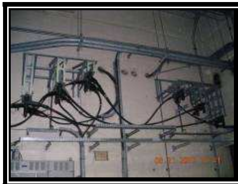
Fig. 1. 3.- Tomas modulares de 30 kVca pertenecientes a Metro de Caracas C.A.
