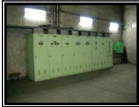
Fig. 1. 14.- Tablero de control y mando perteneciente a Metro de Caracas C.A.
