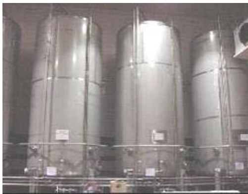
Figura 5. Tanques de almacenamiento de Jarabe terminado
