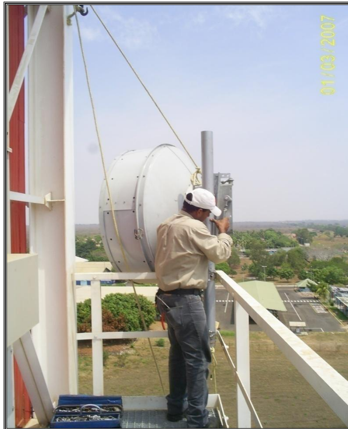
Instalación de antena en torre del Radar
