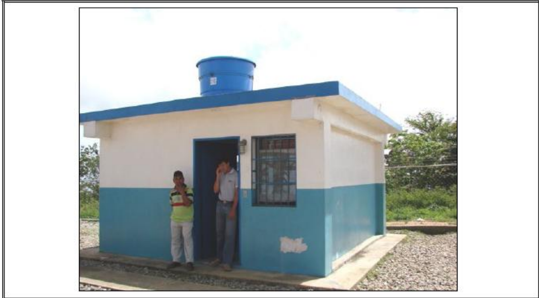
Fachada caseta de vigilancia: ubicación de la antena VSAT.
