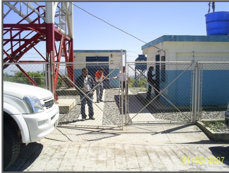
Caseta de vigilancia y de energía
