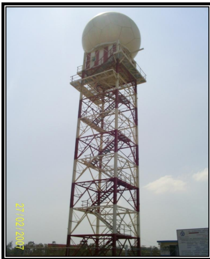
Figura N° 4.5: Construcción civil sitio de radar
