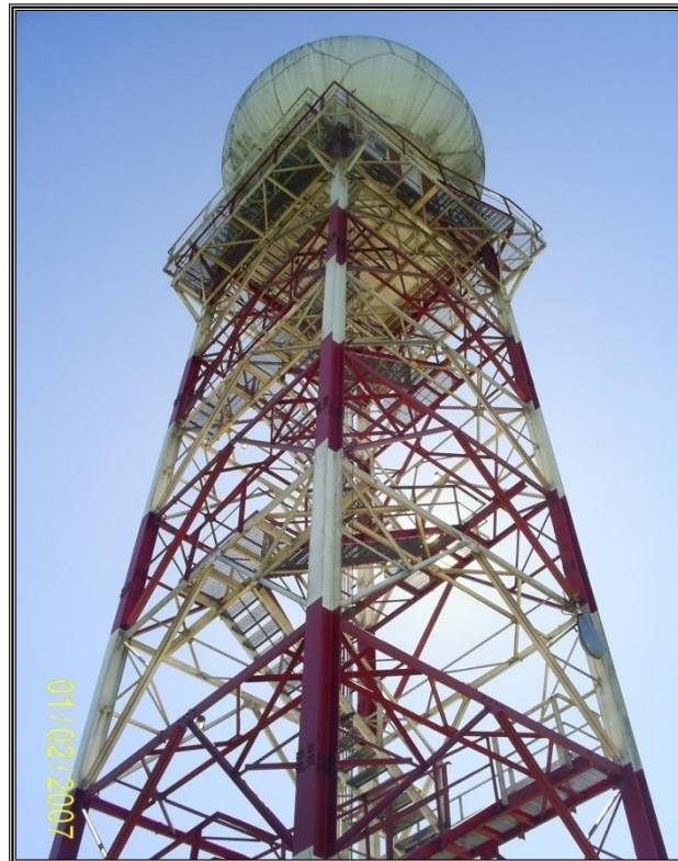
Torre y Radomo
