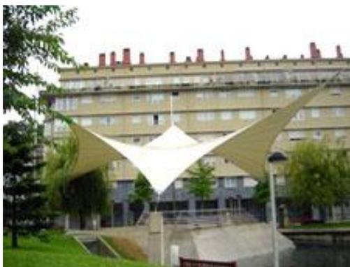
Figura 288. El paraboloides hiperbólico construido como cubierta de tenso-estructura vinílica.
