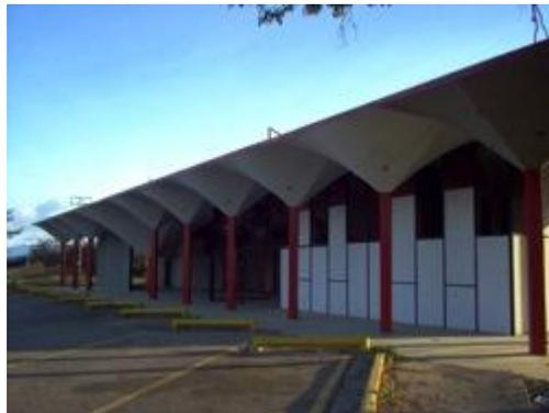
Figura 109. Paraboloides hiperbólicos de la estación de servicios de Los Guayos, estado Carabobo.
