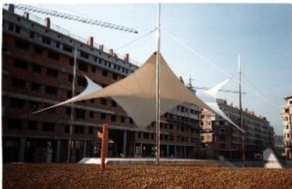
Figura 396. Aplicaciones de paraboloides hiperbólicos en estructura tensil.
