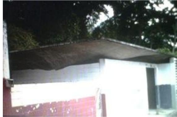
Figura 108. Paraboloides hiperbólicos de la Planta industrial de Paracotos, estado Miranda.
