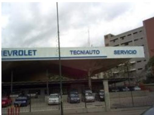
Figura 114. Cubiertas de paraboloides hiperbólicos de concreto armado del concesionario Chevrolet, Los Ruices, Caracas.
