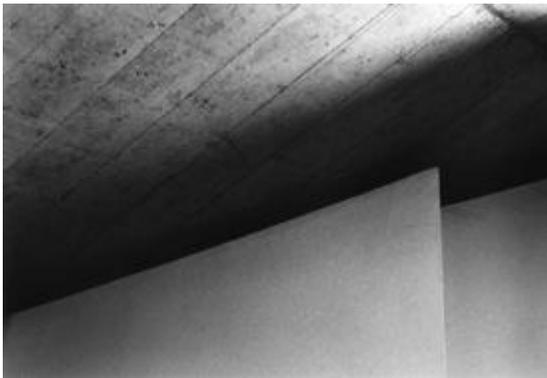
Figura 121. Detalles de la separación "en frío" entre los muros y la cubierta de paraboloides hiperbólicos en la casa Coll.
