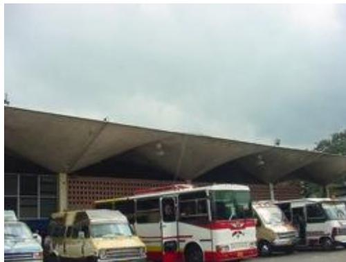
Figura 147. Vista interna de las cubiertas de paraboloides hiperbólicos de la terminal de pasajeros de San Cristóbal.
