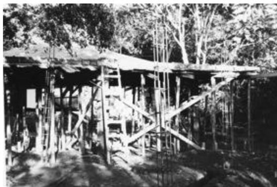
Figura 128. Los techos de la casa del Arq. Julio Coll Rojas una vez vaciado el concreto armado.
