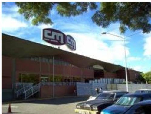
Figura 113. Almacenes militares del IPSFA en Caracas. Paraboloides hiperbólicos de concreto armado en forma de paraguas invertidos.
