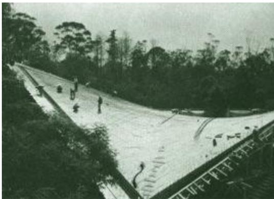
Figura 70. Capilla del Alttillo una vez vaciada la cubierta.
