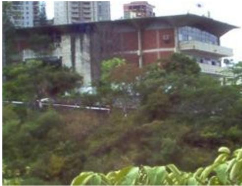
Figura 119. Otra vista desde un ángulo diferente de la cubierta de paraguas invertidos de paraboloides hiperbólicos del edificio administrativo en del Club Táchira en Caracas.
