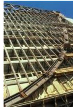
Figura 234. Detalle del arco de catenaria como estructura portante en el edificio Minneapolis, Estados Unidos.
