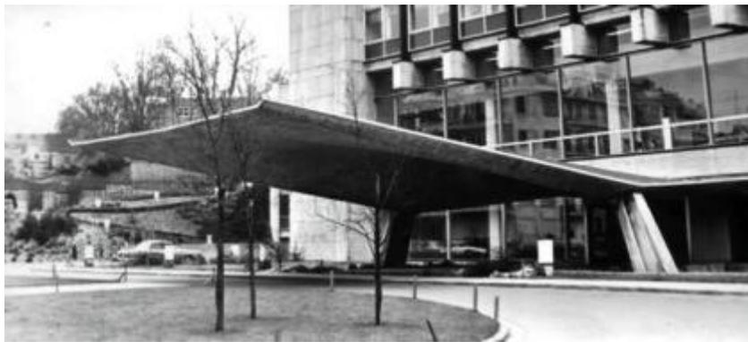
Figura 44. Cubierta de concreto armado formada por cuatro unidades de paraboloides hiperbólicos, similar a la de Lafaille, construida por Paduart en la universidad de Bruselas.
