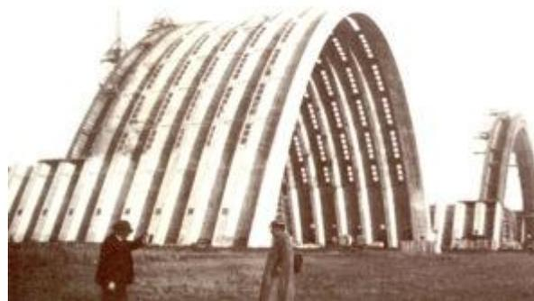
Figura 209. Colocación de cerramientos para la estructura parabólica en acero diseñada por Eugene Freyssinet.
