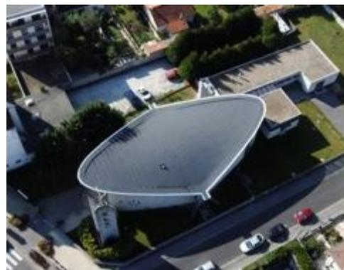
Figura 42. Solución del paraboloide hiperbólico de la iglesia.
