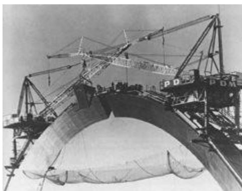
Figura 225. Colocación de las piezas finales en el Arco de Gateway.
