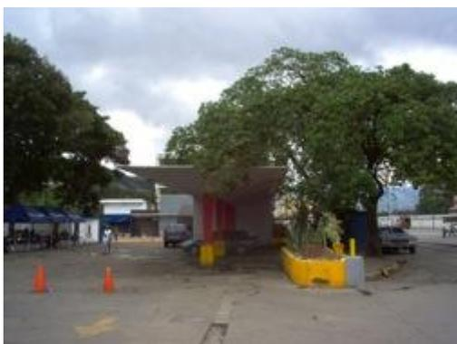
Figura 137. Paraguas invertidos de paraboloides hiperbólicos del área de servicio eléctrico automotriz, y de las oficinas de la Estación de Gasolina de Coche en Caracas.
