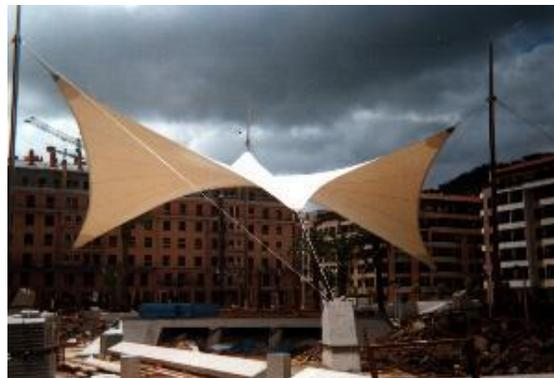
Figura 397. Aplicaciones de paraboloides hiperbólicos en estructura tensil.
