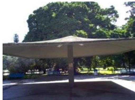
Figura 102. Detalle de la deformación perimetral en el paraguas de la Plaza del Paraboloides, UCV-Maracay.
