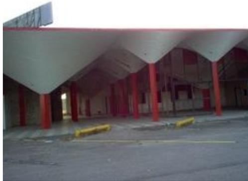
Figura 110. Paraboloides hiperbólicos de diferentes flechas y luces variadas en la estación de servicios de Los Guayos, estado Carabobo.
