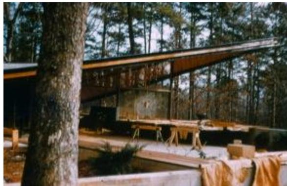
Figura 85. La cubierta de la casa Raleigh, finalmente la doble curvatura fue obtenida con elementos rectos que no requirieron doblez alguno. Fuente: [www.skyscrapercity.com/](http://www.skyscrapercity.com/)
