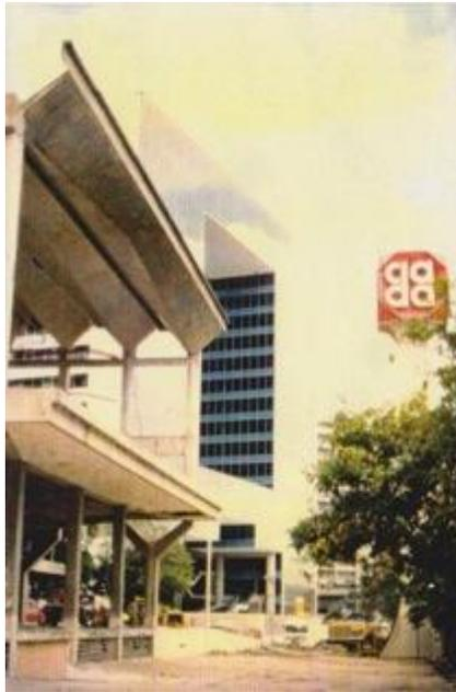
Figura 142. Cubiertas de paraboloides hiperbólicos de Centro Comercial Canaima se observan el logotipo de Automerados Cada y al fondo el edificio Parque Cristal.
