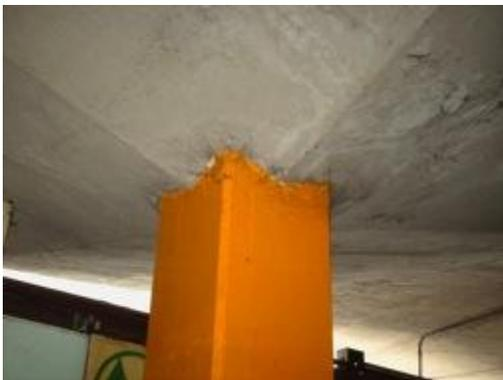
Figura 152. Detalles de mala terminación en el concreto armado de la Terminal de Barinas.
