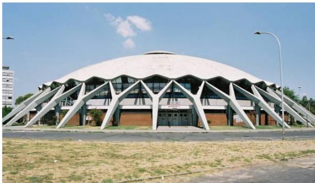
Figura 241. El Palazzio Sport proyecto de cúpula en concreto armado diseñada por Pier Luigi Nervi, Roma, Italia.
