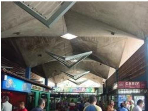
Figura 146. Vista interna de las cubiertas de paraboloides hiperbólicos de la terminal de pasajeros de San Cristóbal.
