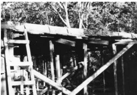
Figura 127. Encofrados para las cubiertas de paraboloides hiperbólicos.
