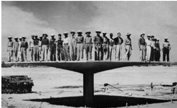
Figura 57. Prototipo experimental en el almacén de Las Aduanas, Colonia Vallejo México, D.F.
