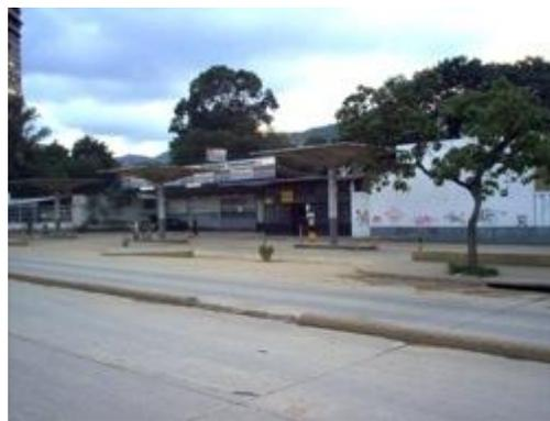
Figura 136. Conjunto de cubiertas de paraboloides hiperbólicos en forma de paraguas invertidos ubicados en la estación de gasolina de Coche, Caracas los cuales fueron demolidos en su totalidad.
