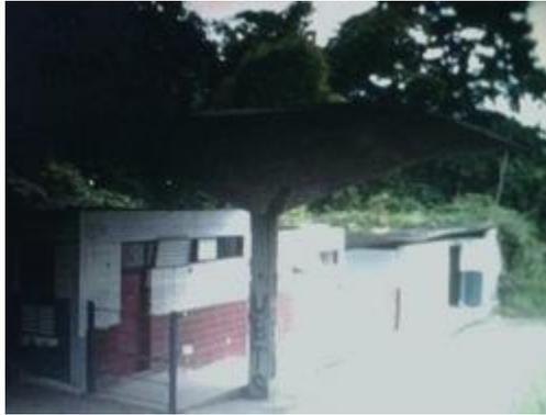
Figura 107. Paraboloides hiperbólicos del acceso de una Planta industrial en abandono ubicada en Paracotos, estado Miranda.
