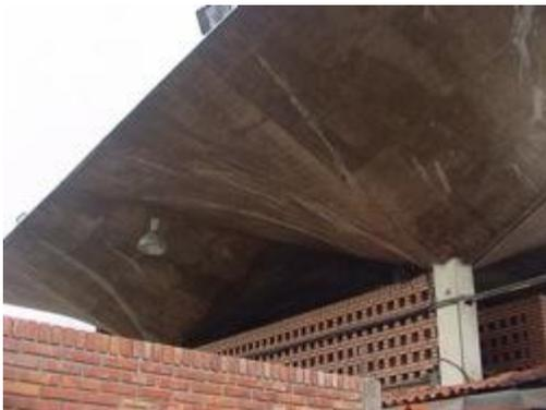
Figura 149. Condiciones y apariencia del concreto armado en el exterior de las cubiertas de la Terminal de pasajeros de San Cristóbal.
