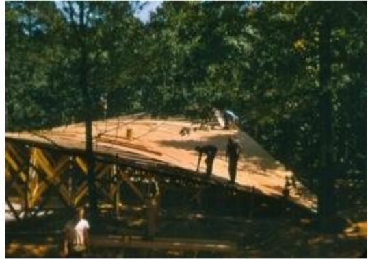
Figura 84. Otra de las fases de construcción de la cubierta de la casa Raleigh, aplicación del cerramiento con tablas de madera. Fuente: [www.skyscrapercity.com/](http://www.skyscrapercity.com/)
