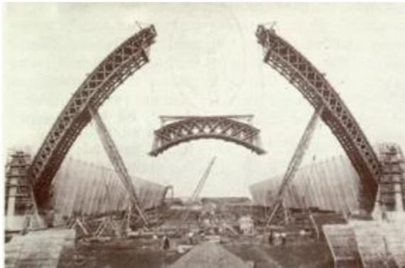
Figura 208. Montaje de la estructura de un hangar diseñado por Eugene Freyssinet.
