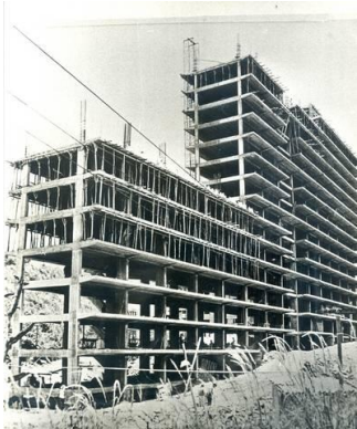
F.15. Multicelular en construcción
