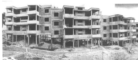
Fig. 2. Bloques El Silencio en construcción, Caracas
