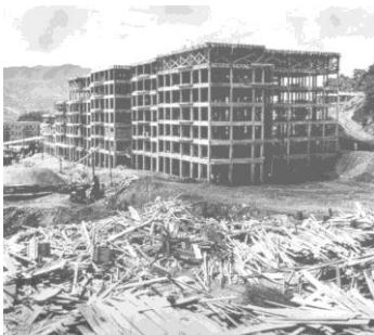
Fig. 3. Bloque 1 El Silencio en construcción
