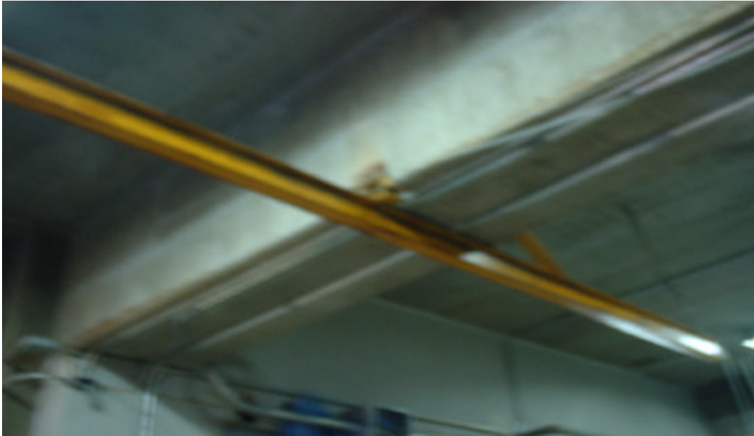
Viga BC. Pórtico 2. Sótano. Biblioteca Central
