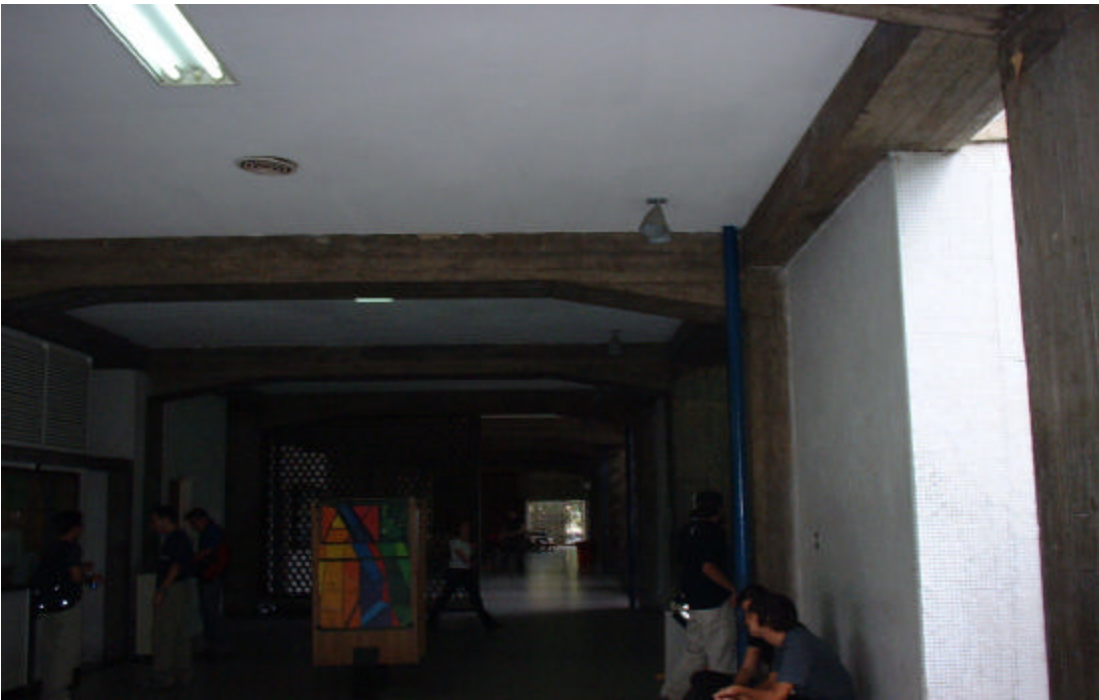
Viga CD-PB. Facultad de Arquitectura
