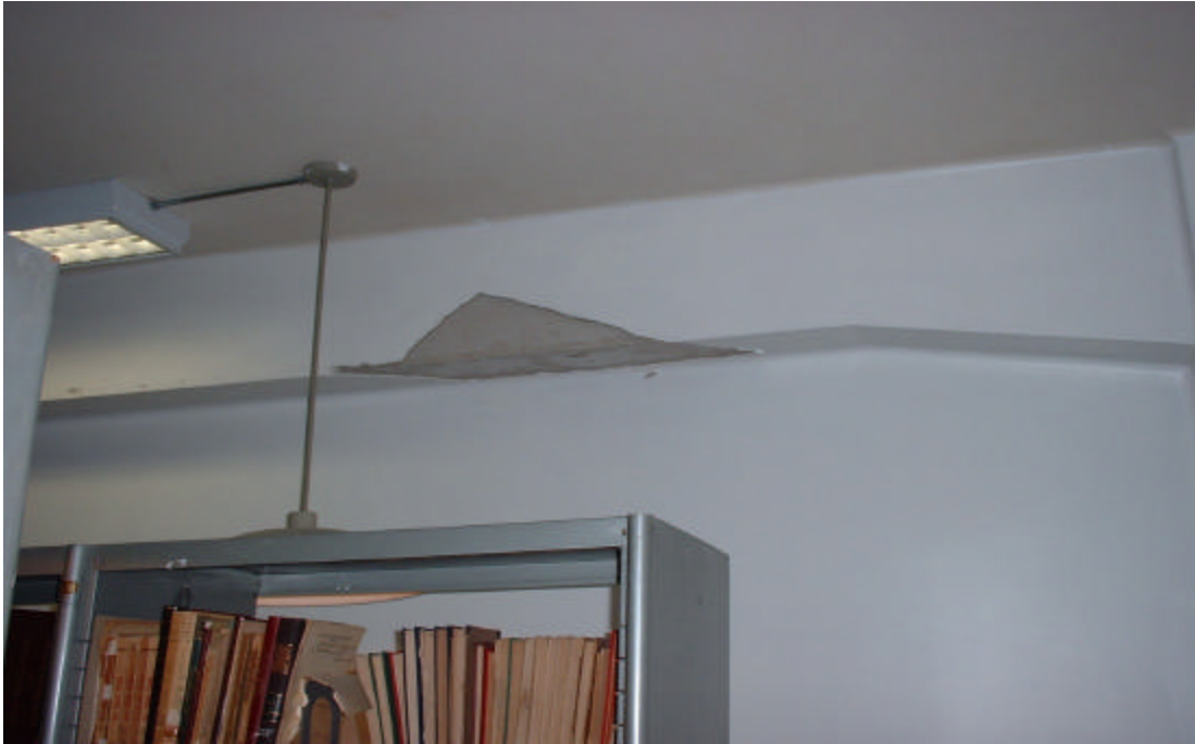
Piso 4. Viga CD, Eje 10. Biblioteca Central
