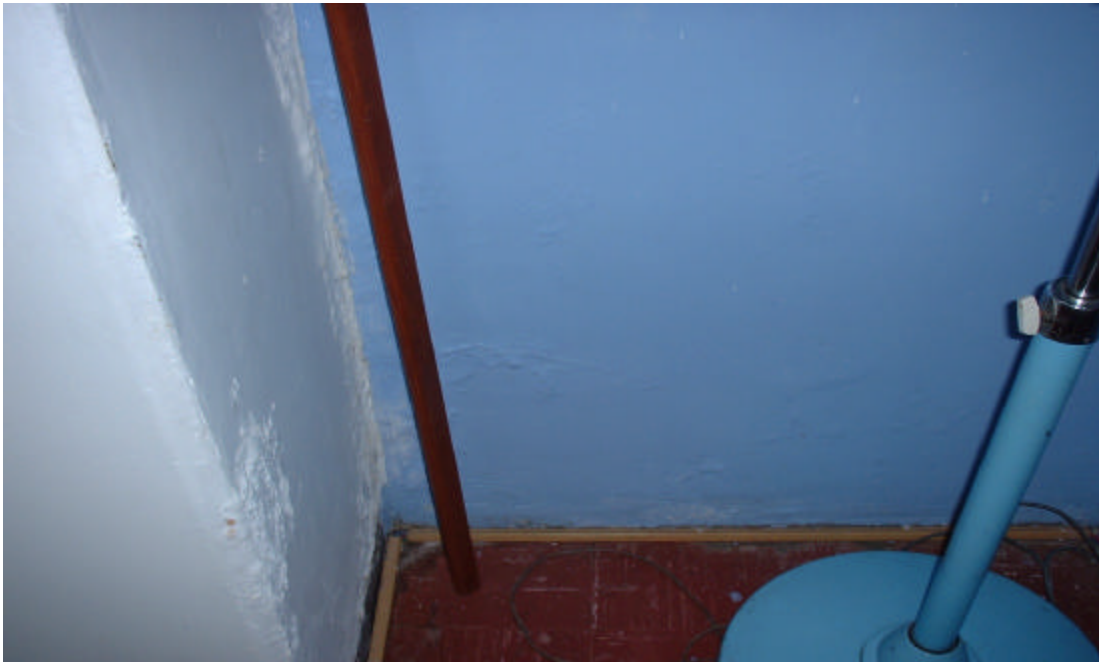
Columna Eje 1A.Piso 1. Biblioteca Central
