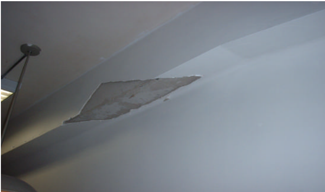
Piso 4. Viga CD, Eje 10. Biblioteca Central
