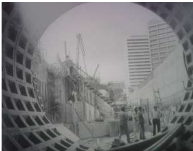
Fig. 9 Construcción de los túneles línea 1, Metro de Caracas.
