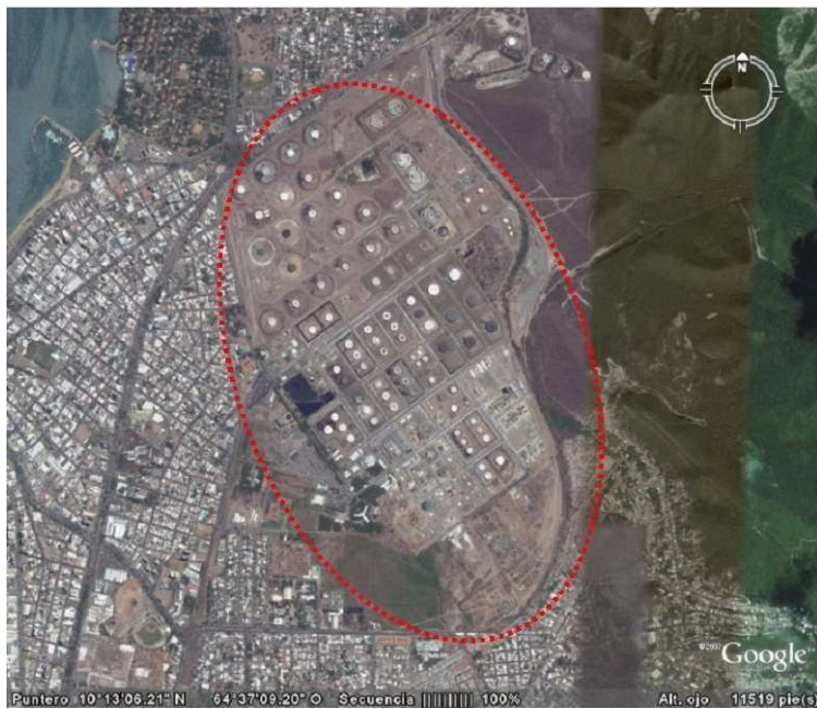
Figura 10: Foto satelital de la Refinería Puerto la Cruz (origen Google Earth)
