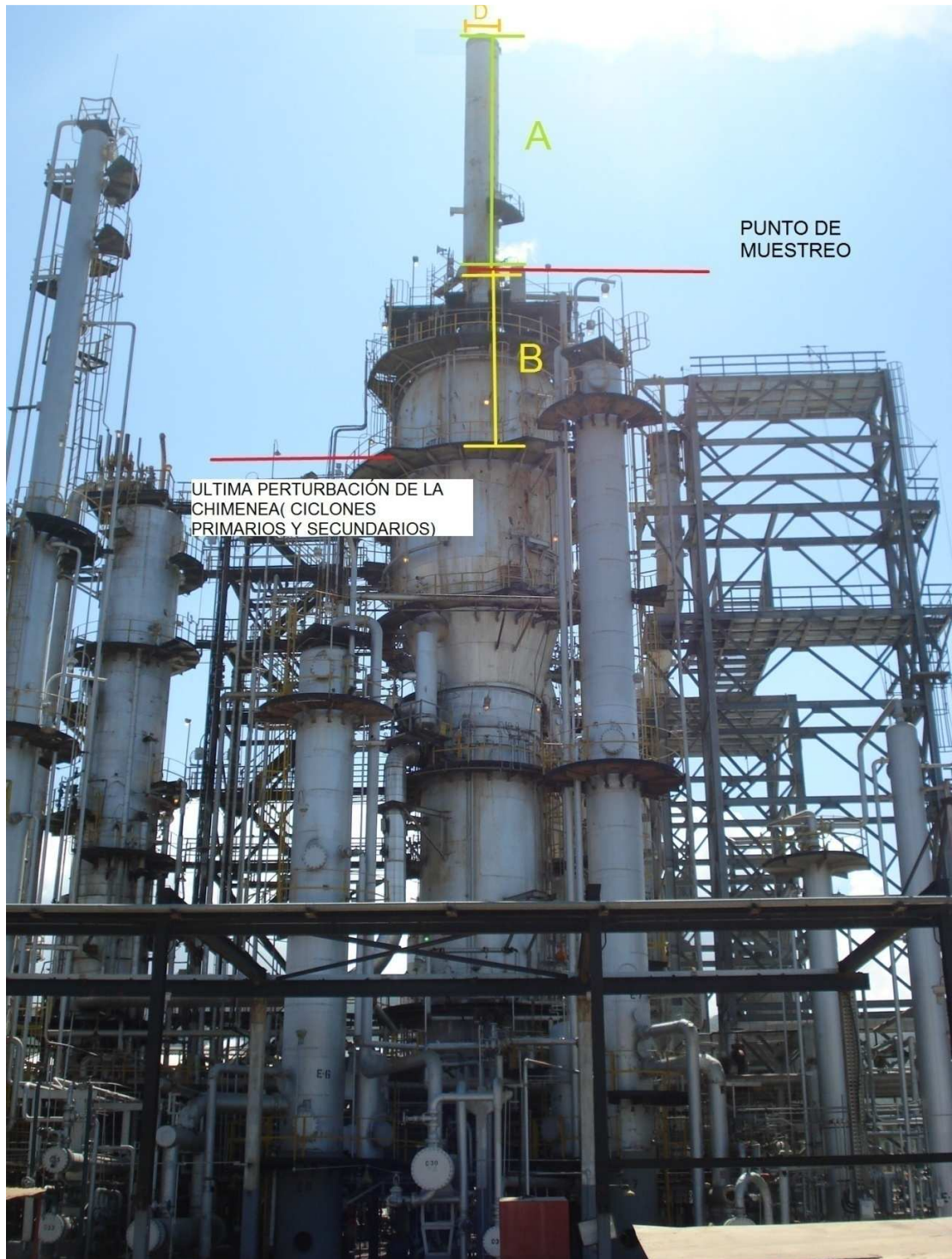
Figura 25: Imagen de la UFCC con señalamiento de parámetros.
