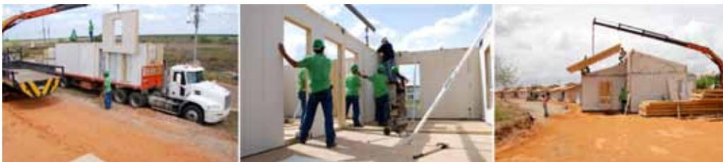
Transporte y montaje de Iso componentes en obra
