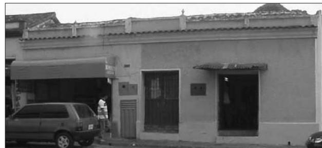
destaca el zócalo o franja inferior que generalmente es coincidente con el encepado de los muros de tierra. Las viviendas ubicadas en la esquina presentan un remate redondeado, como se muestra en la foto 3.
