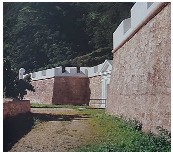
Imagen 24. Fuerte San Carlos de La Guaira
