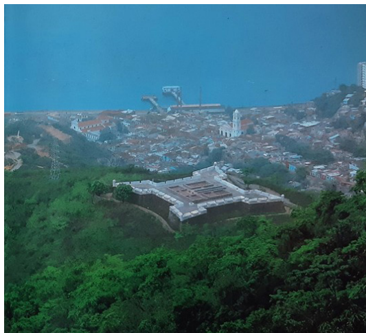
Imagen 23. Fuerte San Carlos de La Guaira
