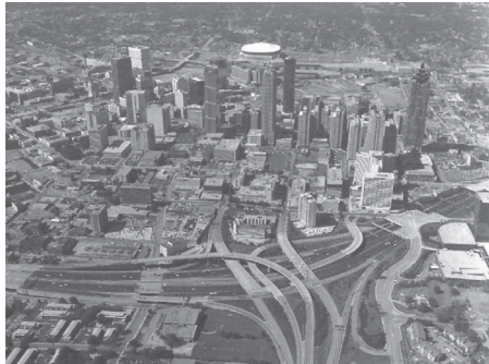
Área central de ciudad estadounidense
